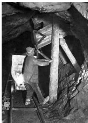
Tramoggia di scarico del minerale Photo by Fondation grand Paradis e Comune di Cogne
