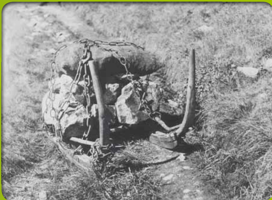
Slitta per il trasporto del minerale dai filoni del vallone di Liconi al deposito dell'Entrepôt (Archivio S.N. COGNE).
